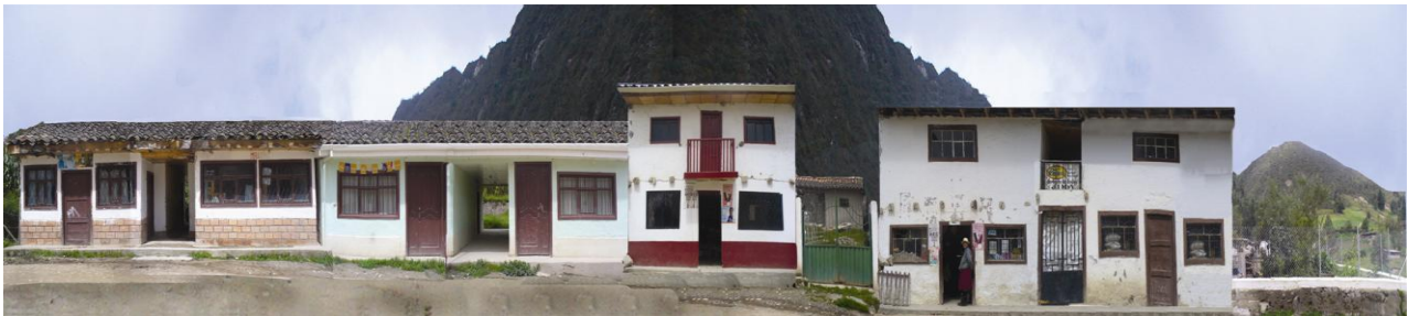
70.- Fotografía N° 50. Tramo 04. Avenida Amazonas entre Huinara y Luís Vargas (lado sur)
