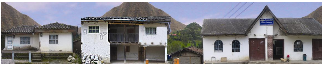
71.- Fotografía N° 51. Tramo 05. Avenida Amazonas entre Huinara y Luís Vargas (lado Norte)
