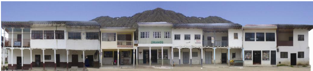
69.- Fotografía N° 49. Tramo 03. Avenida Amazonas entre Luís Vargas y Ramón Zhunio (lado norte)
