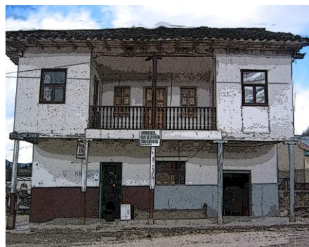
23.- Fotografía 11.- Vivienda tradicional de Gima.
