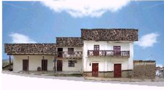
60.- Fotografías N° 48. Tramo N°4. Alonso de Cabrera. (Sur).
