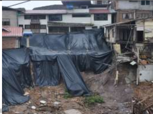
Fotografía 14: Estado actual del inmueble IBI-07-13-50-000-000011, Inspección 29 de diciembre de 2021.
