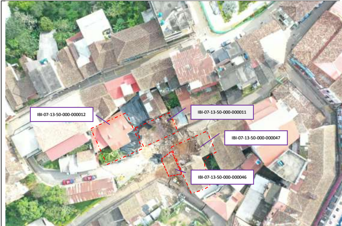
Fotografía 13: Estado actual de la Zona 0, Inspección 29 de diciembre de 2021.
