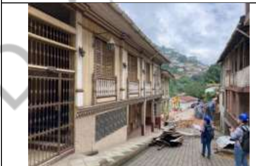
Fotografía 28: Inspección al inmueble IBI-07-13-50-000-000047, Inspección 29 de diciembre de 2021.
