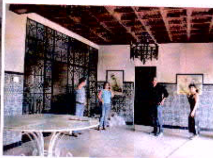
Proceso de verificación de las afectaciones del inmueble
