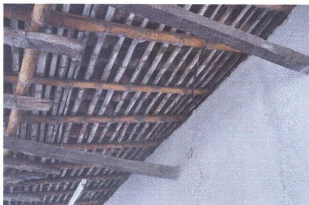
**FOTOGRAFIA NRO. 4.** Deterioro de revestimiento de alero y estructura de cubierta.
