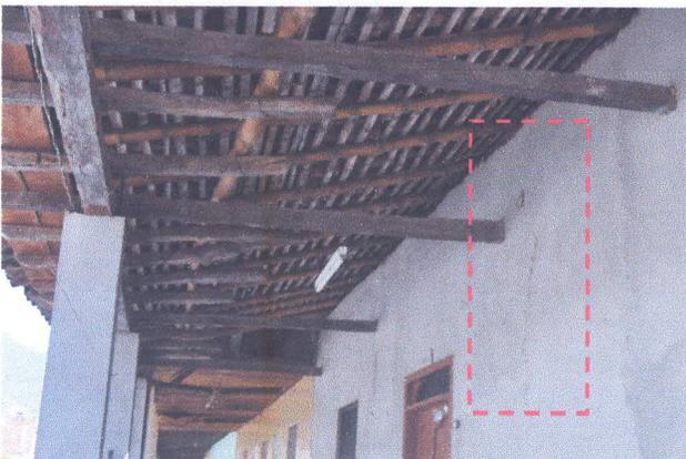
**FOTOGRAFIA NRO. 3.** Deterioro en revestimiento de muros
