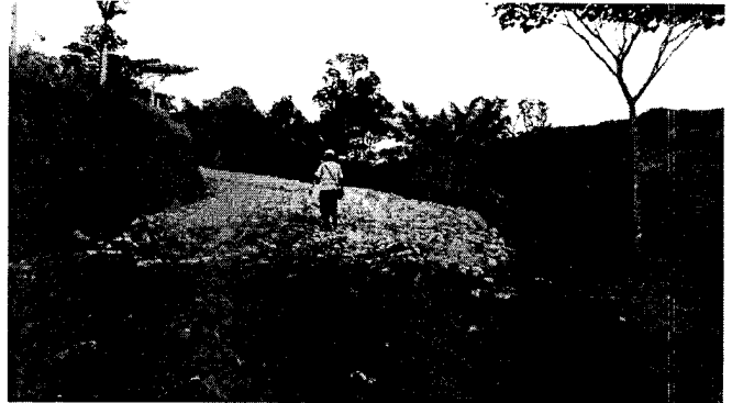
Fotos Nº 1 y 2: Colocación de sub base en la vía a casa de máquinas
