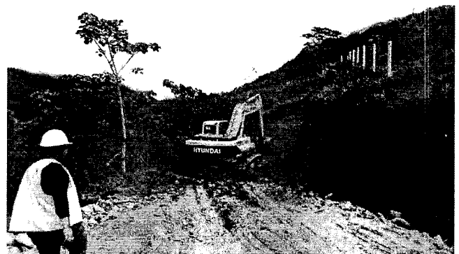
Fotos Nº 3 y 4: Cortes de talud en la vía a casa de máquinas
