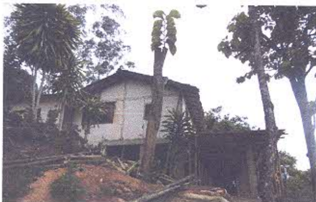
Foto: detalle de intervención realizada.
