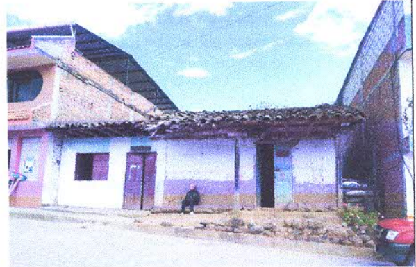
Fotografía nro. 2: Fachada de acceso a la edificación
