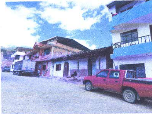
Fotografía nro. 1: Entorno urbano de la edificación. Calle 10 de Agosto
