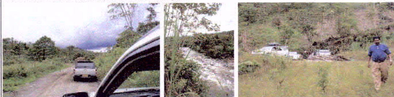
13H00: Filmaciones en el área del puente sobre el río Chiguaza.
