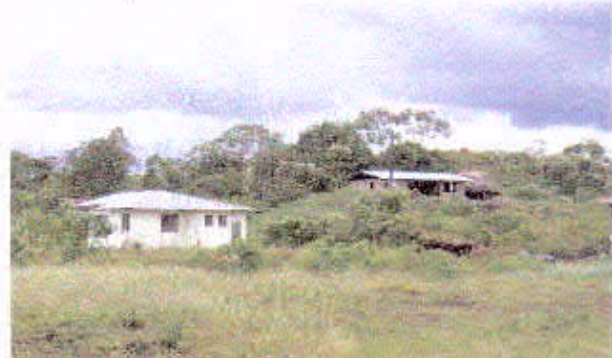
Plataforma sur en el cuadrante 17S151631, ocupada con edificación contemporánea
