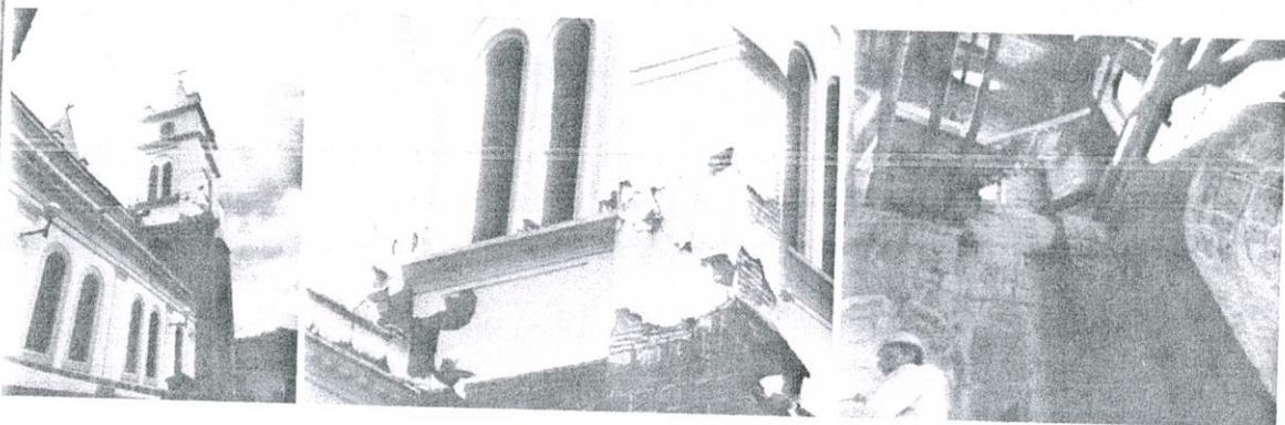
Del análisis estructural preliminar se puede apreciar que el cambio brusco de rigideces de los dos materiales (piedra y ladrillo) y la diferencia de los dos sistemas constructivos provocó el desplazamiento (desprendimiento) uno de otro en el momento del sismo, ya que posiblemente no existe algún tipo de arriostamiento o elemento estructural de anclaje entre los sistemas constructivos mencionados en los muros.
