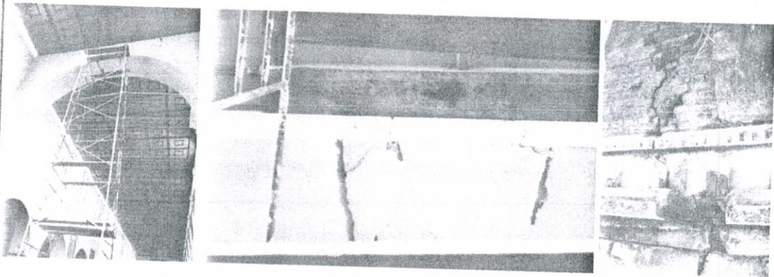
La torre del lado Noroeste, se encuentra con daños de magnitud considerable; esta torre ha sido construida en tres tipos de materiales; primer tramo de piedra sillar trabada, el segundo de mampostería de ladrillo con mortero de cal y arena, y el tercero como remate de hormigón armado (pináculo).
