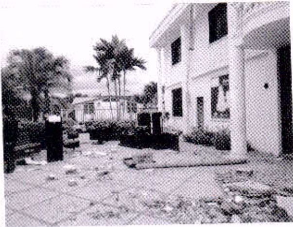
FOTO 3. Evaluación de daños del contenedor
