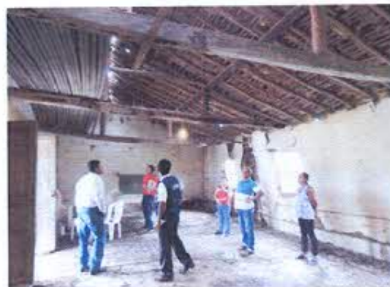
Fotografía nro. 5: Relevamiento del espacio interior de la escuela con características patrimoniales denominada América en la parroquia Cazaderos.
