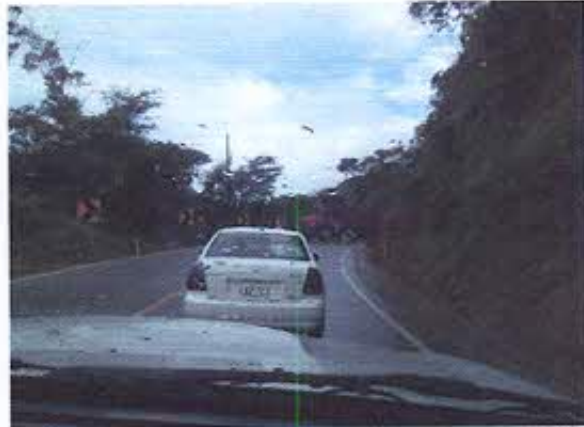
Fotografía nro. 10: Presencia de derrumbes en el retorno de Pindal a la ciudad de Loja.
