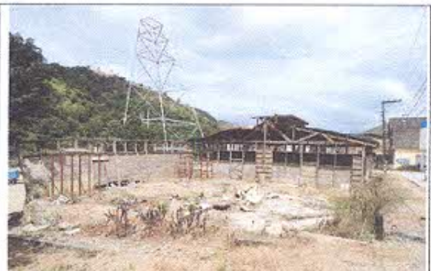
Fotografía 2: Inspección al inmueble IBI-07-11-50-000-000109 - Antigua Bodega de la SADCo
