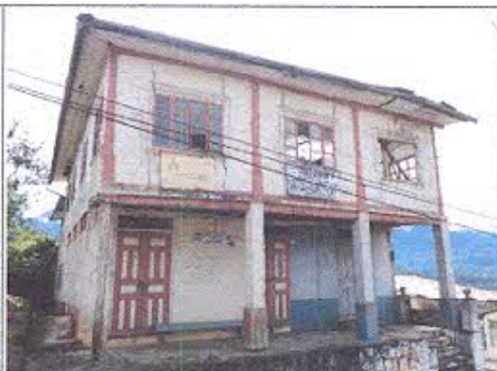
Fotografía 4: Inspección de asesoría técnica al bien inmueble IBI-07-03-51-000-000002. Parroquia Ayapamba
