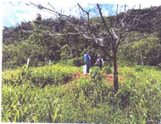
Foto 7.-Torre T266 construida sin monitoreo arqueológico.
