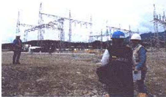
Foto 1.- Vista de la Subestación Bomboiza en donde se construye la torre T248A.
