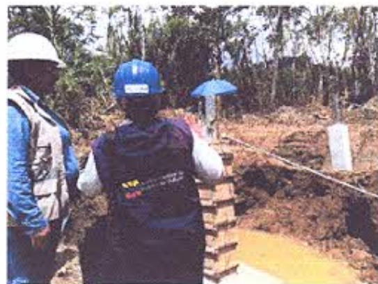
Foto 4.- Torre T256 en proceso de construcción, se realizó monitoreo arqueológico.
