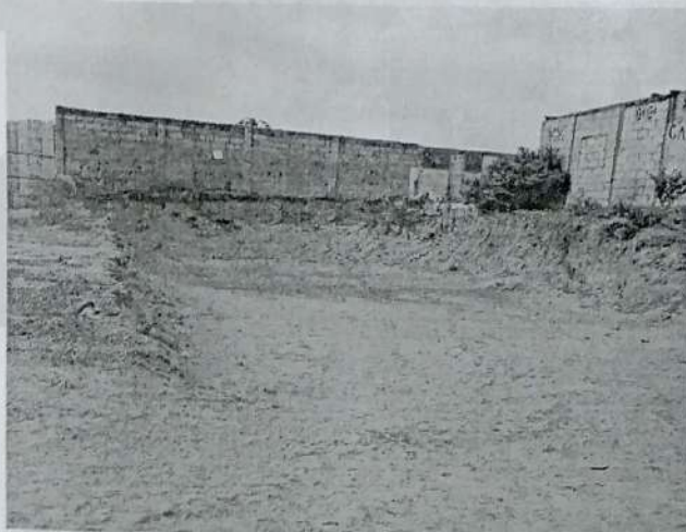
PANORAMICA DEL SITIO AFECTADO
