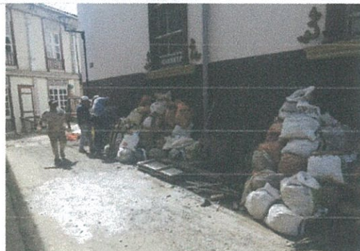
Fotografía 6: Seguimiento trabajos Iglesia Matriz Zaruma
