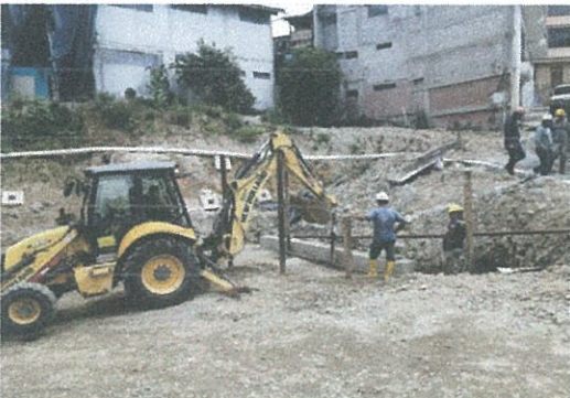
Fotografía 5: Monitoreo de trabajos en zona 0 socavón 15 diciembre 2021
