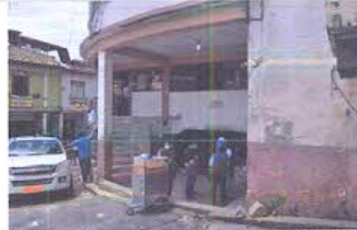
Fotografía N°4: Levantamiento del Bien Inmueble Patrimonial "Mercado Municipal" en la fase de Evaluaciones de Edificaciones Esenciales del Cantón Zaruma.
