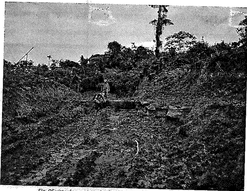
*Fig. 06 vista de apertura de vía y bloques de roca ígnea en el camino.*
