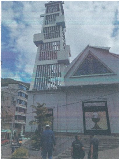
Fotografía nro. 1: Inspección iglesia Piñas. IBI-07-10-50-000-000057.
