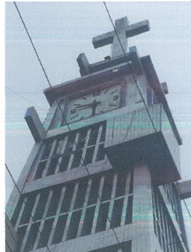
Fotografía nro. 2: Inspección iglesia Piñas. IBI-07-10-50-000-000057.
